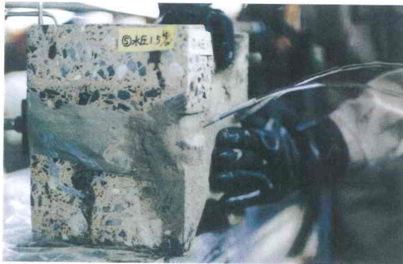
写真-3. 1 漏水状況（試験体No. 3）
